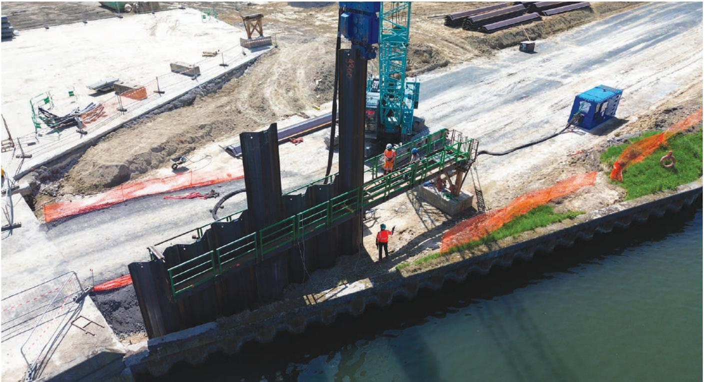
Le récent démarrage de la pose des palplanches marque une étape symbolique et technique de la future plateforme fluviale de l'usine de recyclage Galloo. La construction du mur de palplanches, qui a vocation à retenir les terres et à servir de soutènement au futur quai, traduit l'entrée concrète d'un projet d'envergure dans sa phase de réalisation, avec des enjeux multiples pour le territoire, ses habitants et l'environnement.
