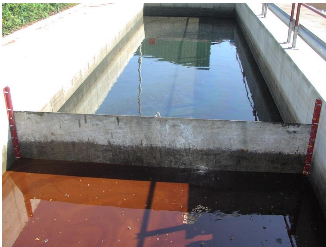
Figure 1 : exemple d'une installation de prétraitement réalisée par Trevi
