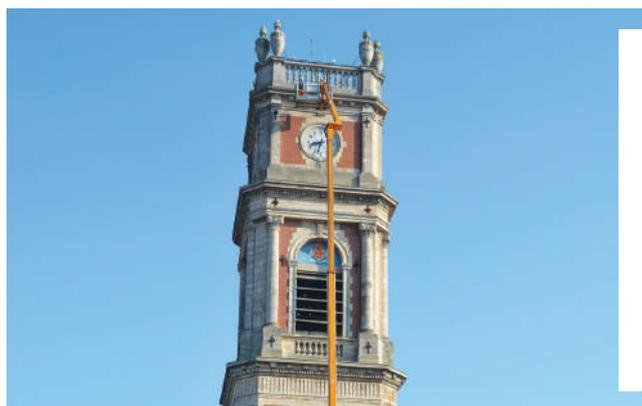
**B**onne nouvelle pour les amoureux du patrimoine local, les travaux concernant l'**église Saint-Martin** vont débuter début novembre. D'une durée de 2 mois, les travaux extérieurs vont permettre de consolider la structure avec un nouveau ferrailage et le maçonnerie des corniches. L'intérieur de l'édifice va connaître quant à lui quelques aménagements avec la reprise des éléments bétons. Ces travaux représentent un investissement de 79.435€.
