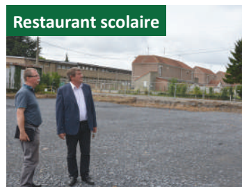
Terrassement réalisé : construction imminente
