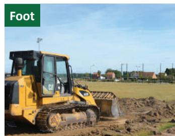
Mise en place d'un terrain synthétique au stade Bouthemy
