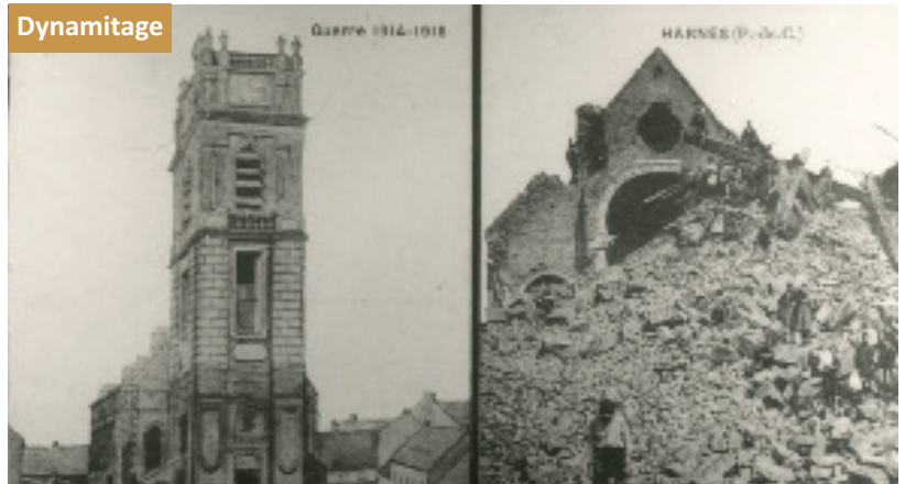
A gauche, l'église construite au XVIII ème siècle et à droite, ce qu'il reste de l'église après son dynamitage par les Allemands
