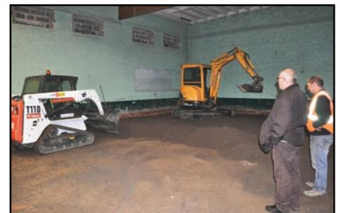
puisqu'étalé sur une couche de grave traitée compactée, sur 50 centimètres d'épaisseur, y verra d'abord le jour. Les conditions seront alors les bonnes pour y assurer le travail d'isolant, suivi du ferrailage, pour aboutir au coulage de la dalle en béton. Il faudra alors aux entreprises observer trois semaines de séchage pour à nouveau intervenir.
