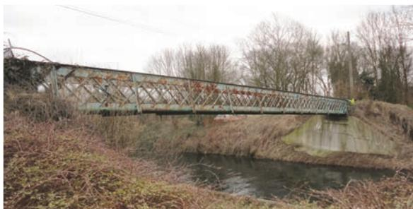
Suite aux mauvaises conditions météorologiques des derniers mois, un des blocs en béton supportant la passerelle (tablier) située au Bois de Florimond s'est désolidarisé.
